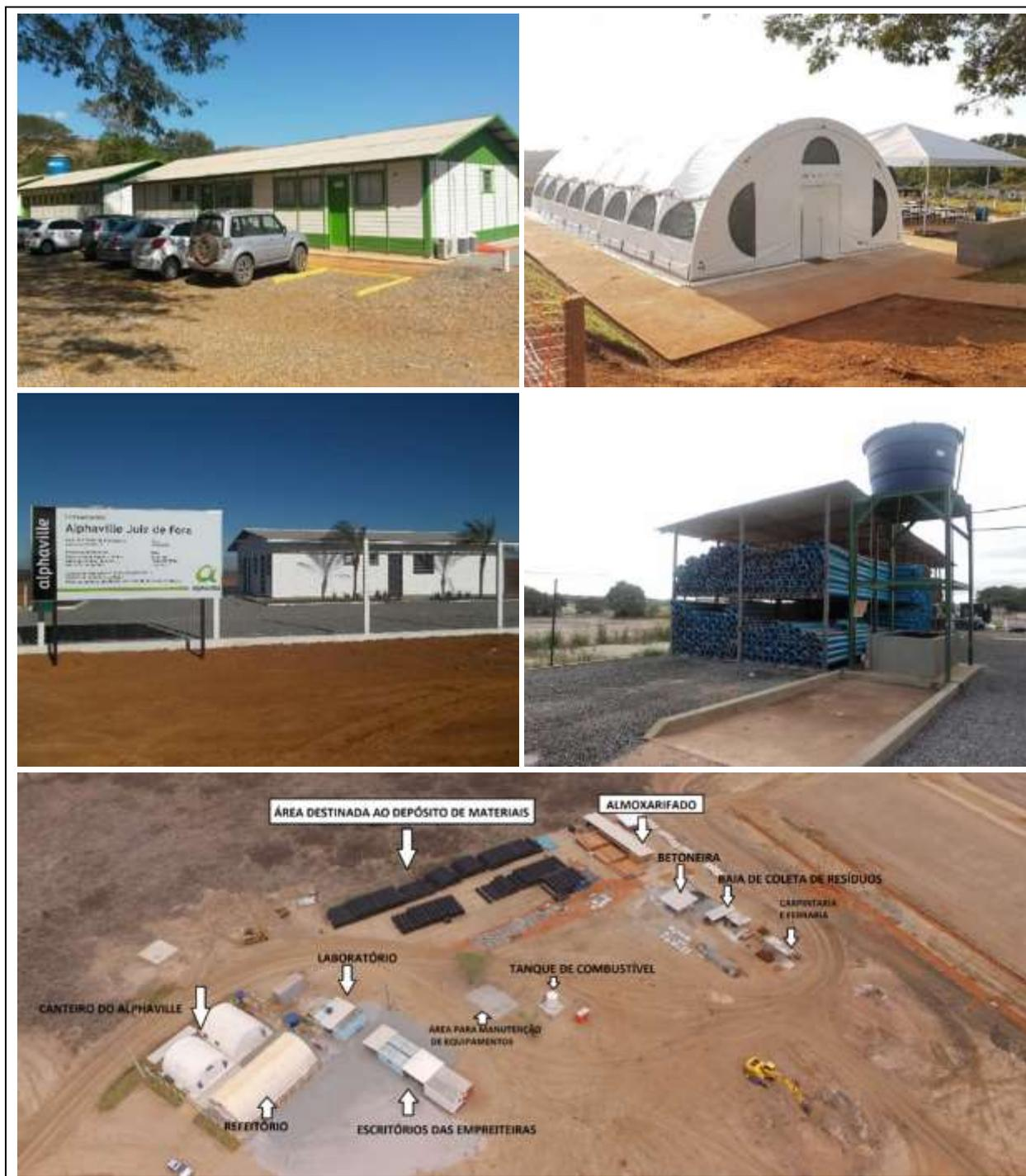
Figura 4.1 – Modelo de canteiro de obras utilizado nos empreendimentos Alphaville
