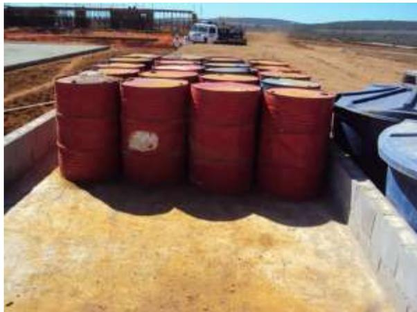
**Figura 4.43 – Armazenamento adequado de recipientes com insumos para a obra**
