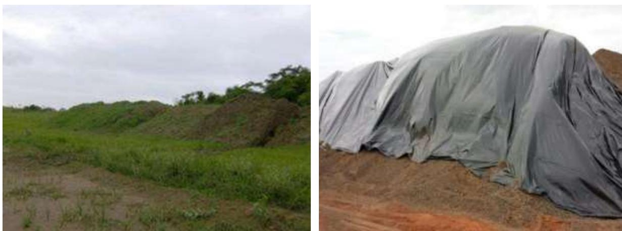
Figura 4.5 – Modelo de armazenagem de solo superficial para posterior utilização
