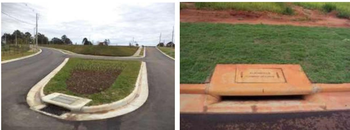
**Figura 4.7 – Detalhe das guias, sarjetas e boca de lobo adotadas pela Alphaville**
