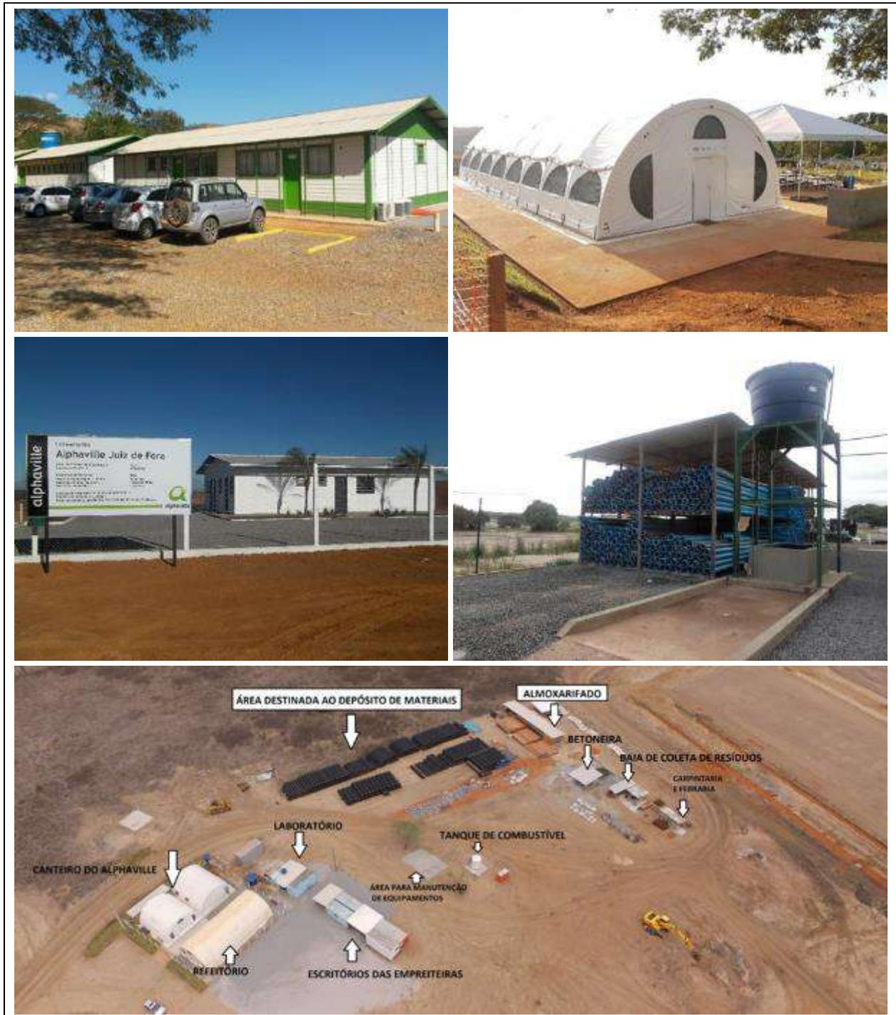
Figura 3.10 – Modelo de canteiro de obras utilizado nos empreendimentos Alphaville
