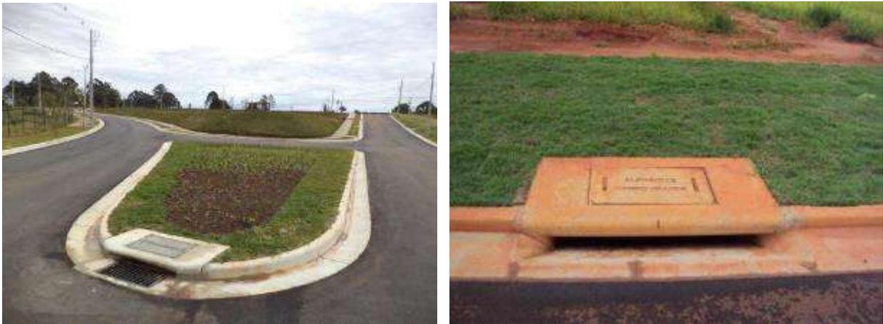
**Figura 3.15 – Detalhe das guias, sarjetas e boca de lobo adotadas pela Alphaville**
