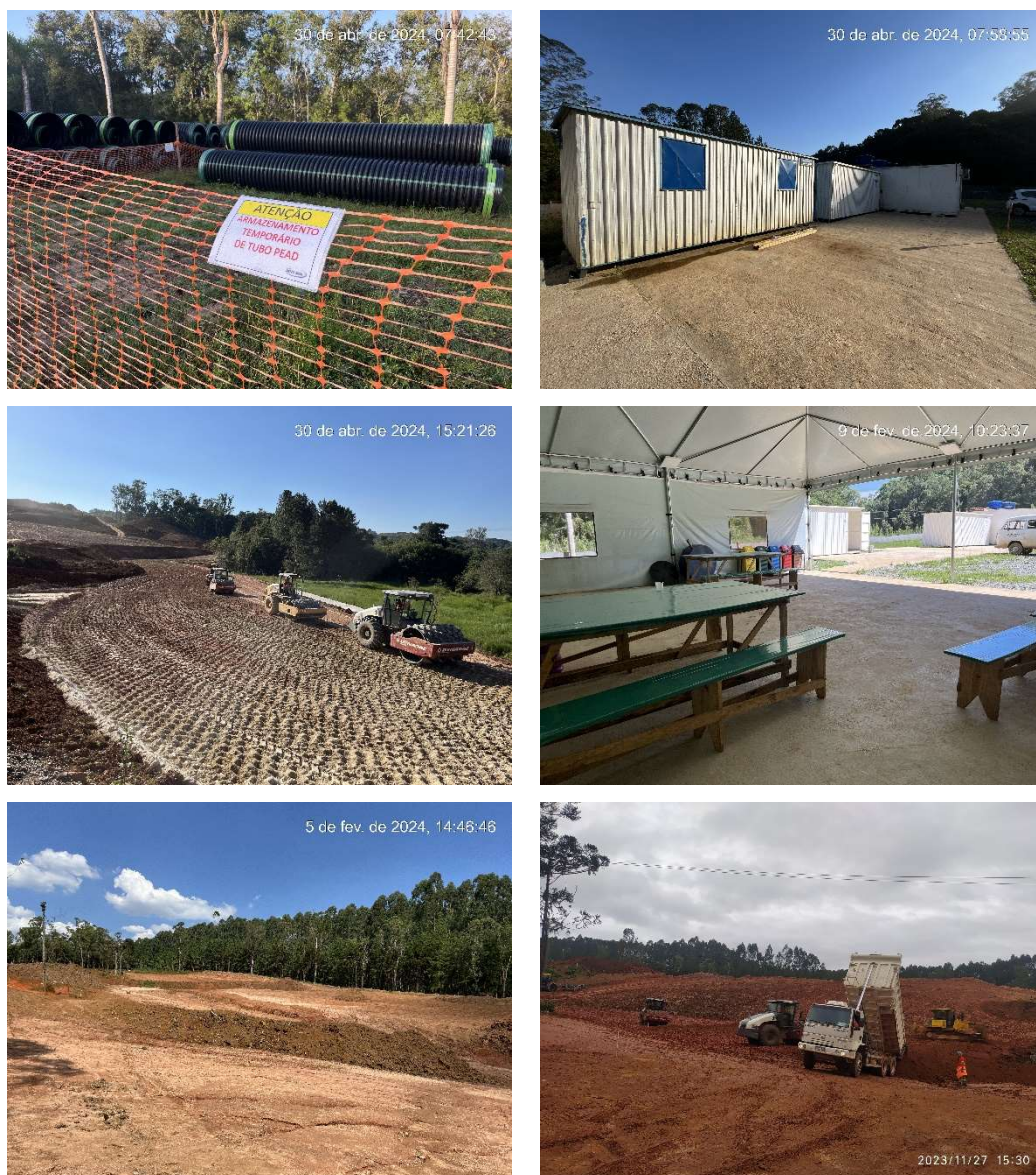
Figura 8 – Limpeza e organização geral do empreendimento
