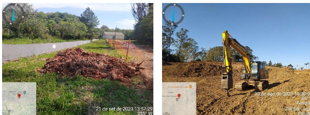
Figura 8 – Destoca, trituração e incorporação do material no solo
