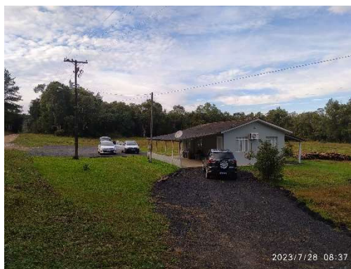
Figura 9 – Escritório técnico administrativo reformado
